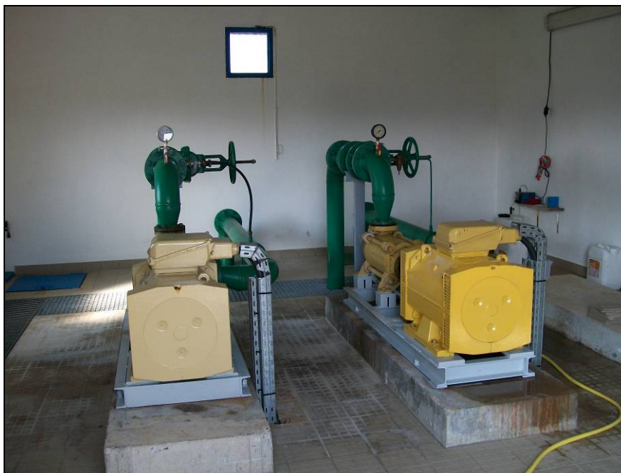
Station de pompage de Lafayette / vue intérieure
